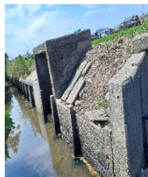
二股メンド近くの法面
