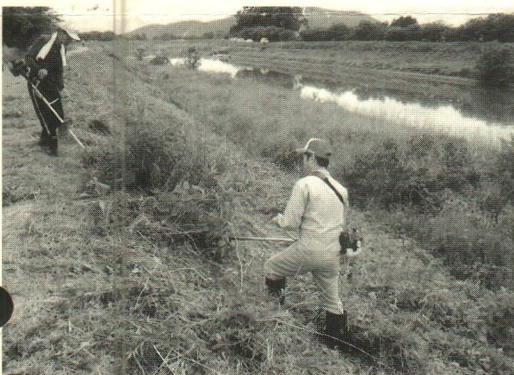
宇曾川堤防草刈り作業
