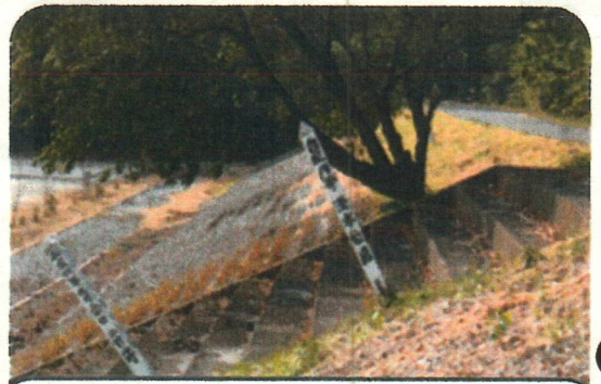
平成2年台風19号の水位実績標柱 ～愛知川堤防：階段上3段（約60cm）～
